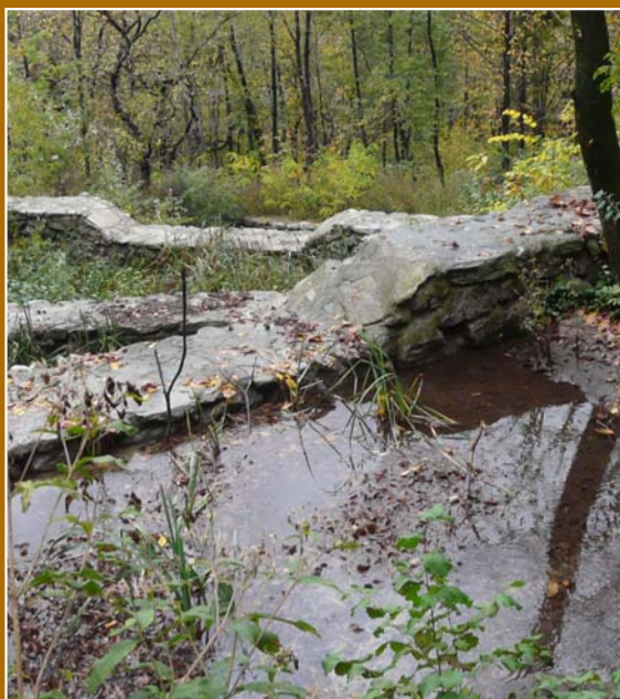
Briglie in muratura, importanti opere di difesa idraulica. Foto: D. Merlo Falchero.
