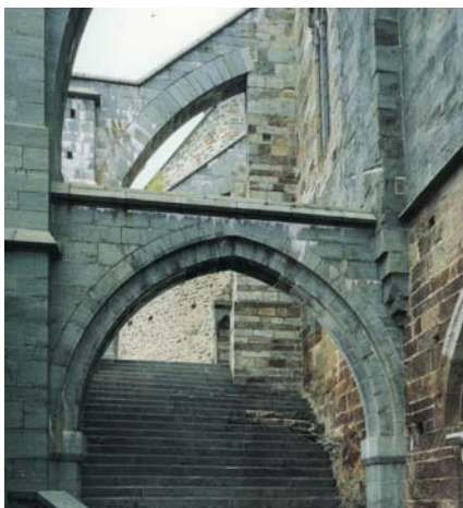
Gli archi rampanti edificati nella prasinite di questa cava, edificati nel primo novecento a sostegno del lato occidentale della Sacra. Foto Archivio Sacra di San Michele.
